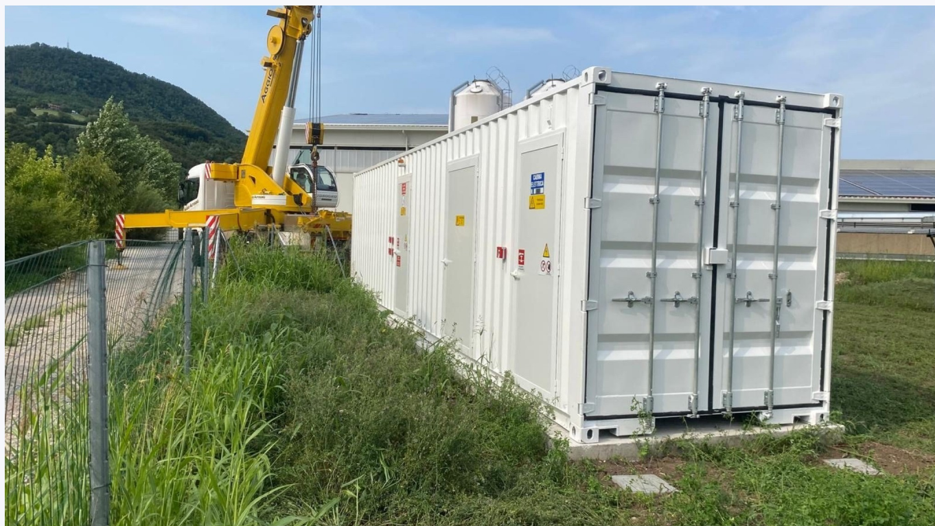
Posa in impianto fotovoltaico · container 40' posizionato con autogrù sul basamento
